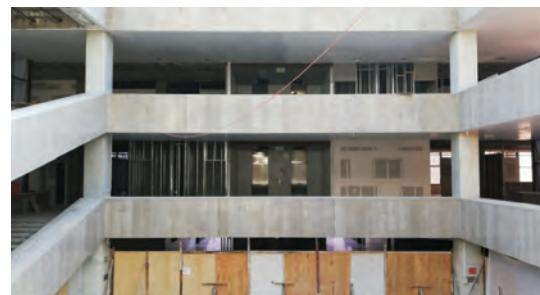
Actualmente se lleva a cabo la colocación de muros divisorios, la canalización de instalaciones hidrosanitarias, de instalaciones eléctricas y la colocación de pisos.
